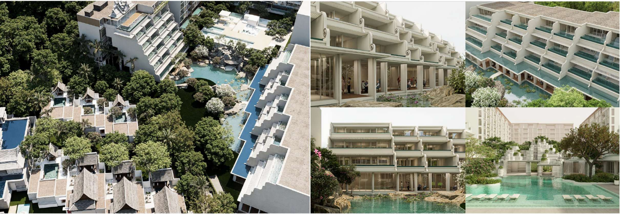
โครงการก่อสร้าง Intercontinental Phuket (Extension Phase)
