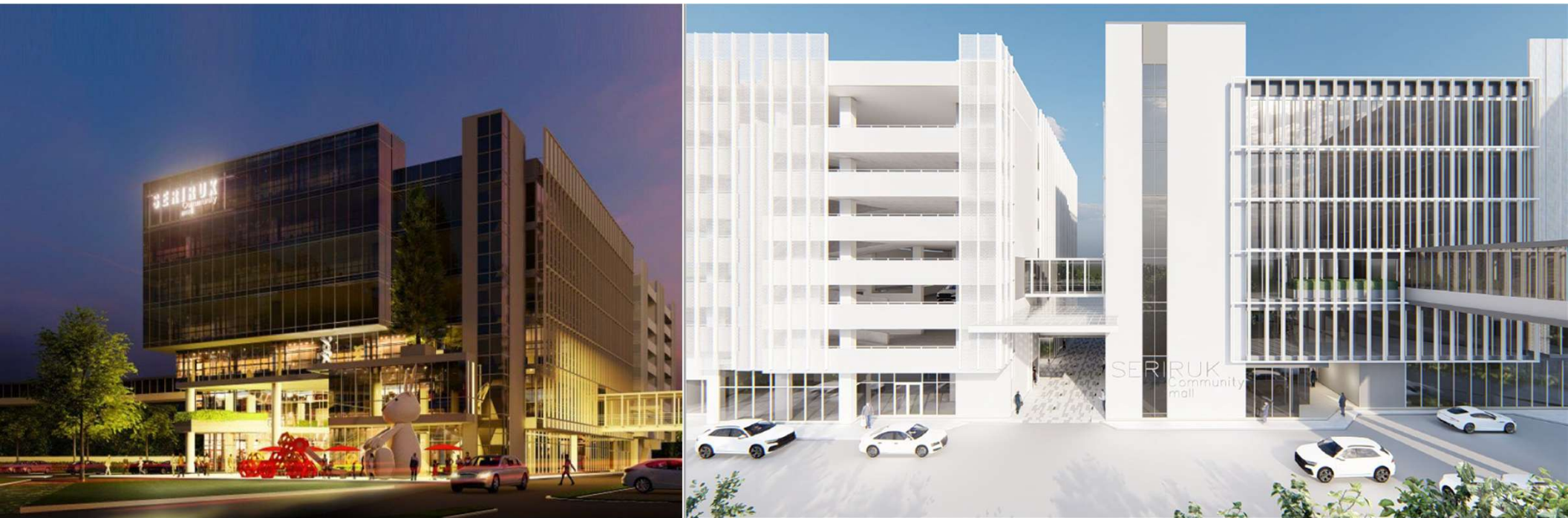
โครงการปรับปรุงโรงพยาบาลสินแพทย์-เสรีรักษ์ และงานก่อสร้างอาคาร Community Mall & อาคาร Car Park
