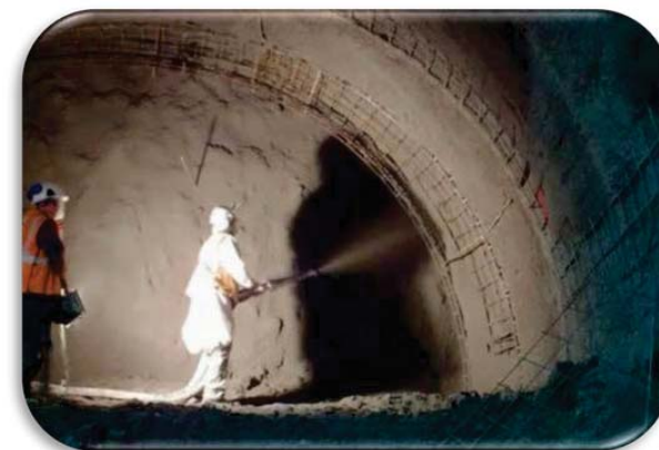
ติดตั้งค้ำยัน ประวัติการทำงาน นายรัช แก้วเรือน
